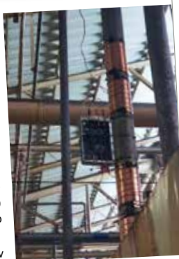
Vulcan S25 byl instalováno přibližně 50 metrů před indukčním kalícím strojem.
