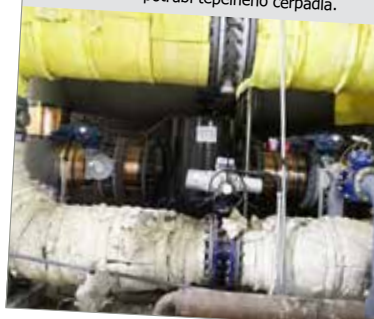
Krok 2: Venkovní instalace, potrubí obaleno izolační bavlnou, X-Pro 2 jednotka v ochranném boxu
