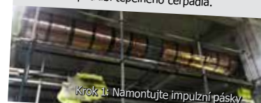
Krok 1: Namontujte impulzní pásy
