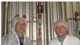
Vulcan instalovaný v potravinářském podniku
